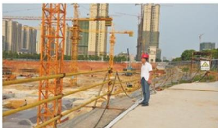
艾切新经理每天都前往各期工地进行现场监督巡查。下午，在四期施工现场，他巡视一番后，站在高处凭栏远眺，凝视前方施工场地，眼神里透露出希冀与坚定。
