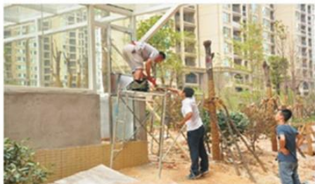
土建监理员黄杰出现在二期地下室出口现场，督促闭门器的安装，保证好的质量需从小事做起，抓好细节问题。
